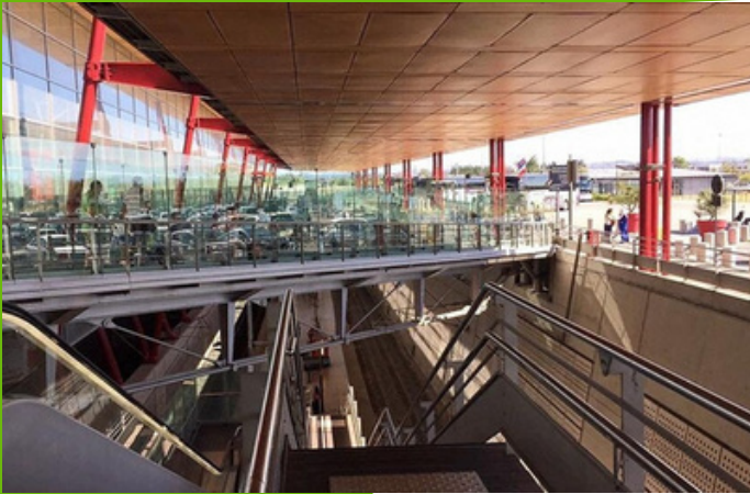
Gare TGV VALENCE, Lauréat du Concours National, MULTIBETON France
