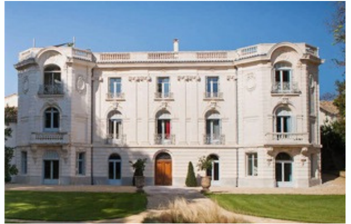
Rénovation Château de BIAR, Classe A+
