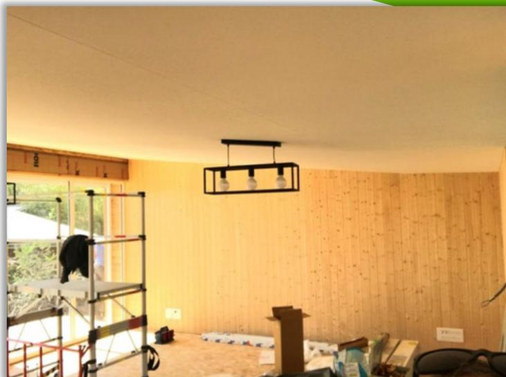
**La plaque est posée dans l'épaisseur du RAIL PLACO à l'aide d'agrafes, 1 plaque au m<sup>2</sup> et 1 mn pour poser 1 m<sup>2</sup>**
